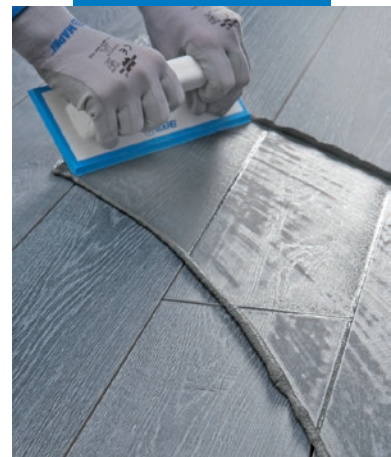
Întinderea chitului Ultracolor Plus cu spatula cauciucată pe o pardoseală din gresie porțelanată cu imitație din lemn
