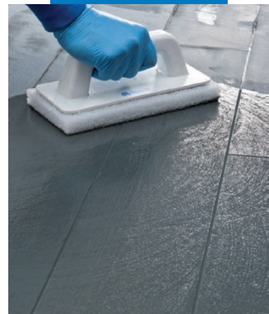
Curățarea rosturilor cu spatula abrazivă Scotch-Brite® (când produsul este semi-întărit)
