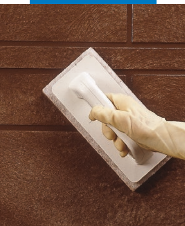
Curățarea rosturilor cu ajutorul buretelui Scotch-Brite® (când produsul a inițiat priza)
