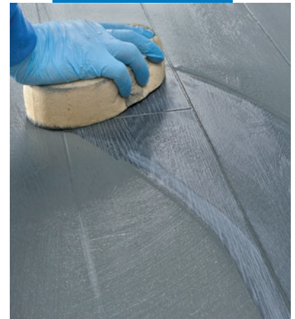
Curățarea și finisarea rosturilor cu buretele de celuloză
