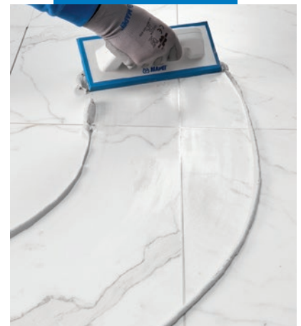
Întinderea chitului Ultracolor Plus cu spatula cauciucată pe o pardoseală din marmură cu efect de porțelan
