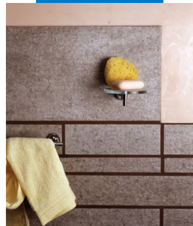
Perete placat cu gresie porțelanată și chituit cu Ultracolor Plus
